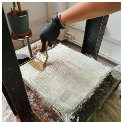
Figura 4.7 Impregnarea straturilor cu amestecul de rășină și întăritor
