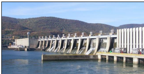
Figură 31 Sistemul Hidroenergetic și de Navigație Porțile de Fier I (Hidroelectrica, 2010)
